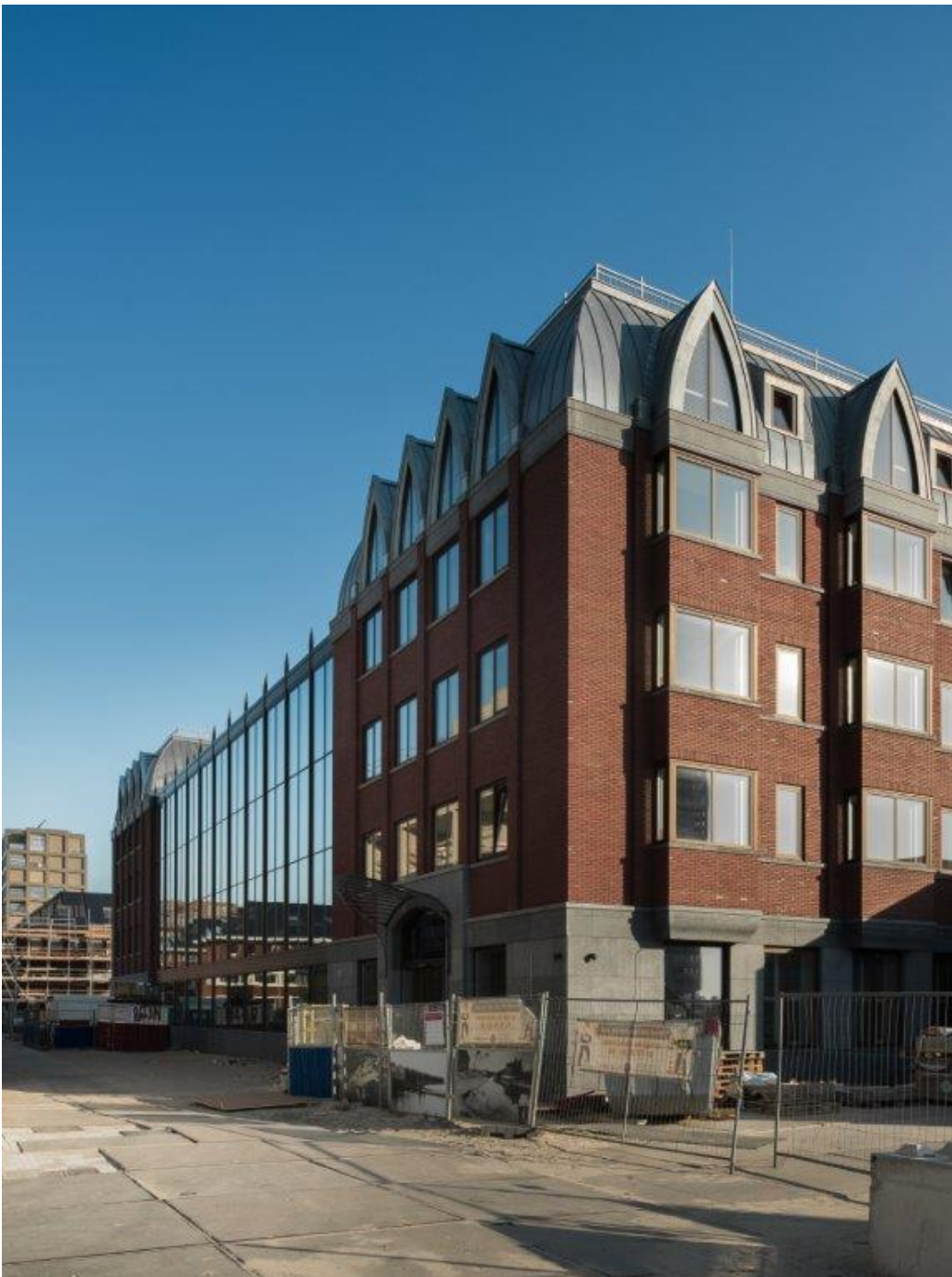
Gevel aan de stadzijde Beeld Max Hart Nibbrig
