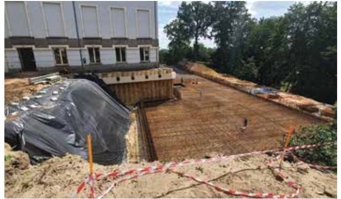
Bouwplaats met palenwand rondom de kop van de bestaande vleugel.
